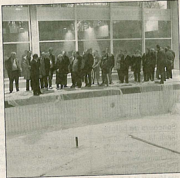
Les enseignants d'Outreau et du Portel ont été invités à visiter le chantier.
