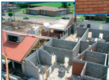
Maison de retraite de ROELUX en construction
