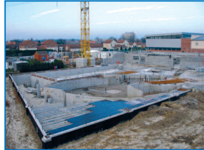
Piscine de Courrières en construction
