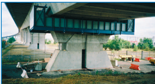
Pile du pont de Cheviré
