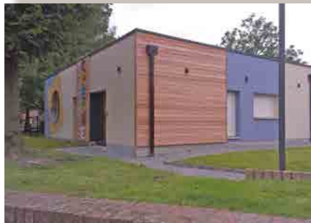
Construction d'une structure petite enfance à ECOURT ST QUENTIN (62) Architecte: SCENARIO ARA
