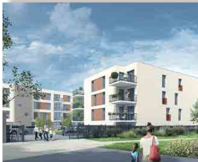
Construction de 63 Logements à Loos (59) Architecte : BBF ARCHITECTES
