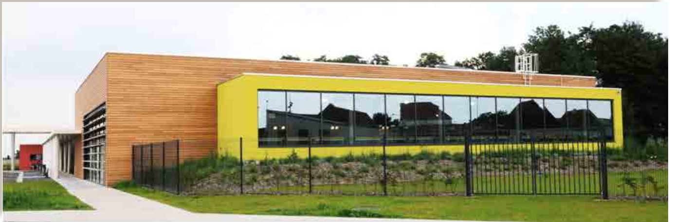
Piscine de Vitry en Artois (62) Architecte : DRD ARCHITECTURE
