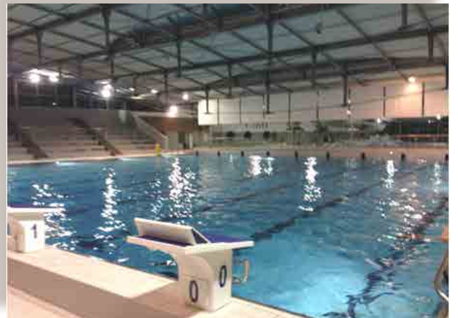
Piscine de Longuenesse (62) Architecte : JACQUES ROUGERIE
