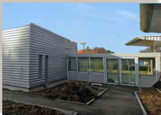
Construction de bureaux et locaux techniques à Raismes (59) Maître d'ouvrage : EDF
