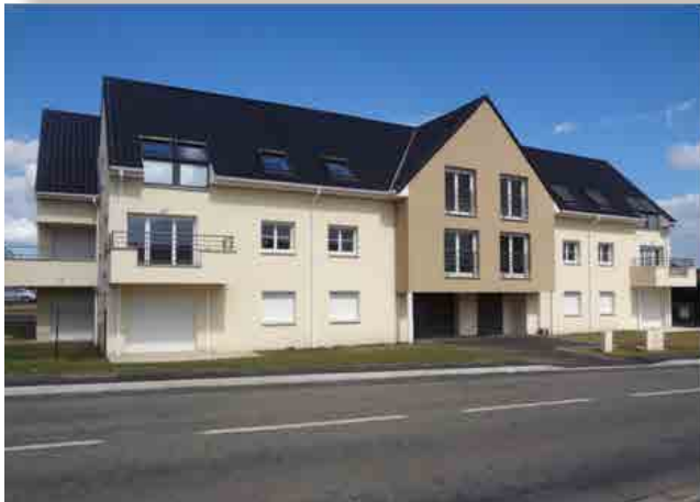
32 Logements à Annay sous Lens (62) Architecte : WALLYN SEZILLE
