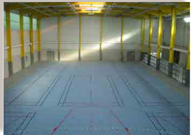
Salle de Sports de Liévin (62) Architecte : CABINET DAMIENS ET ASSOCIEES
