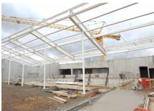
Charpente en cours de pose par BC MÉTALNORD
