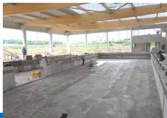
Étanchéité du bassin en cours de réalisation
