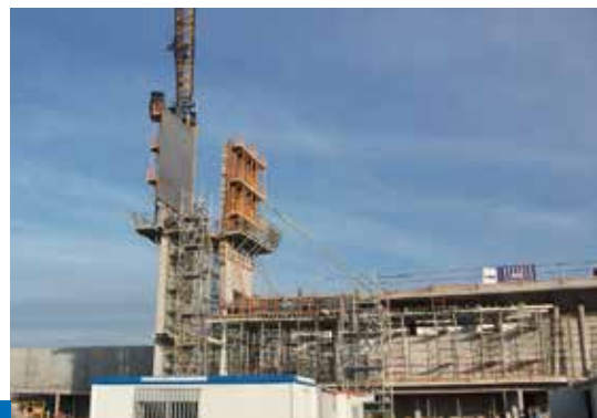
Réalisation des voiles béton du beffroi
