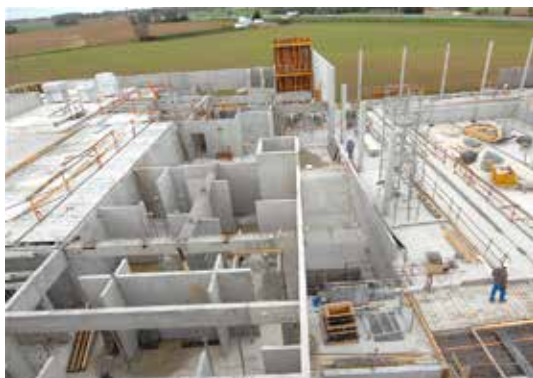
Voiles des vestiaires et génie civil du bassin sportif qui sera revêtu d'inox "INOXEO"
