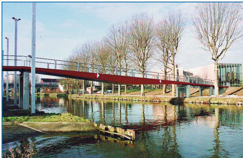
Passerelle mobile entre Lille et Lambersart.
